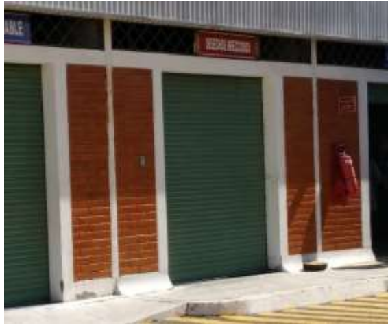
Foto N° 1. área de almacenamiento de desechos infecciosos y peligrosos
