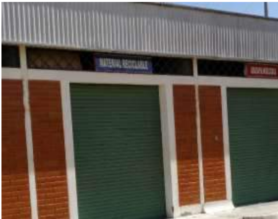
Foto N°. Área de almacenamiento de desechos reciclables
