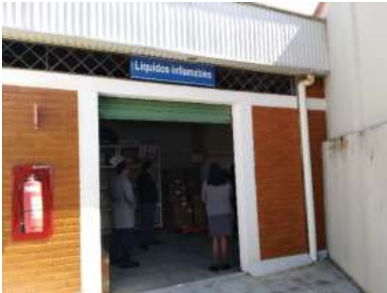
Foto N° 9. Área de almacenamiento de desechos líquidos inflamables
