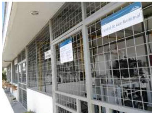
Foto N° 16. Área de almacenamiento de gases medicinales
