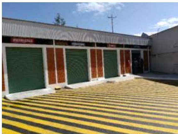
Foto N° 5. Área de almacenamiento de desechos comunes
